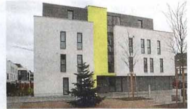
Auf dem ehemaligen Gelände der Nelson-Kaserne an der Gasselstiege wurde fleißig gebaut.
