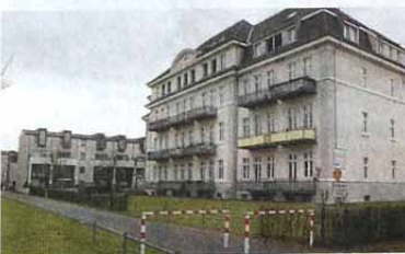
Im Lincoln-Quartier an der Dreizehnerstraße entstanden Wohnungen in ehemaligen Kasernengebäude.
